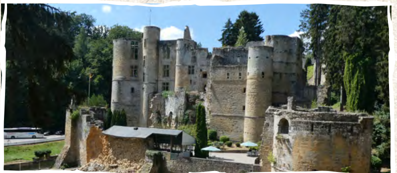
An der alten Burg von Befort ist eine Mauer eingestürzt. Sie wird nun wieder aufgebaut.
